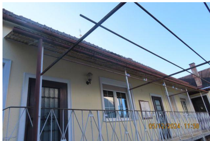
Abb. 10: Wohnhaus mit Laubengang Hofansicht
