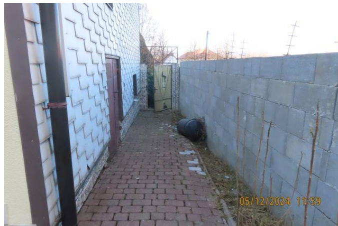
Abb. 9: Wohnhaus Südansicht mit Kellerzugang
